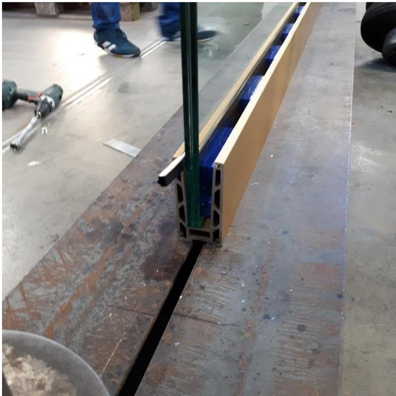
**Abbildung V 00-4: Glas durch Kunststoffkeile fixiert**
