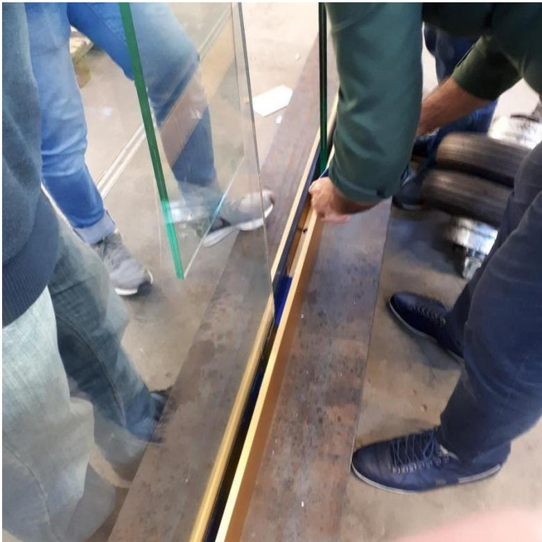
**Abbildung V 00-1: Einbau des VSG-ESG 2x8 in Aluminium Profil KF-1000**
